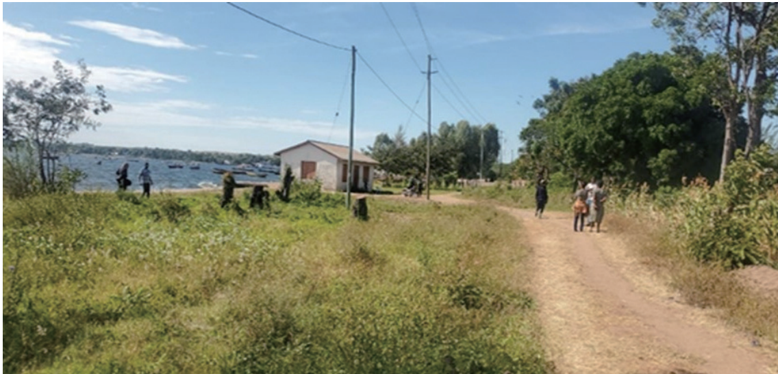
탄자니아 무완자 일레메라 병원선 정박시설 빅토리아 호수 병원선 1, 2호선의 관리와 운영을 위해 본부로 사용될 도크 시설이 긴급히 마련되어야 한다. 월드미션 프론티어는 무완자 시의 일레메라 디스트릭트와 협의하여 호숫가 부지를 확보하고, 2024년부터 도크시설 및 병원 건축을 추진할 예정이다.
